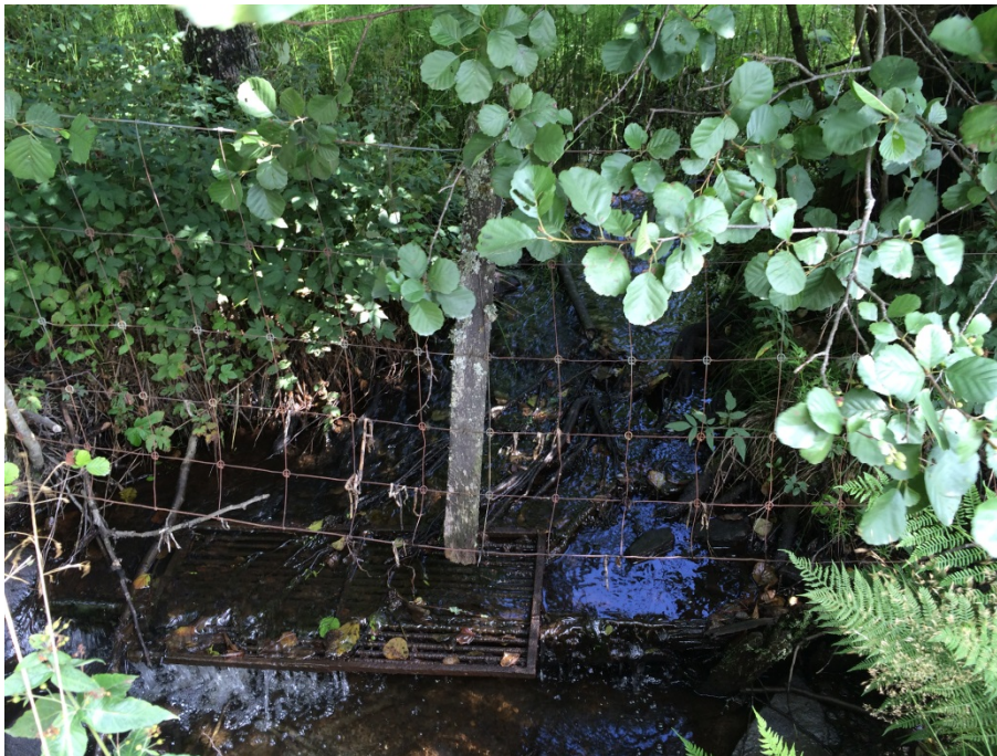
Figur 8. Genom området rinner en bäck till vilken stora delar av dagvattnet från planområdet avleds. Fotot är taget vid en vägtrumma strax norr om planområdet.
