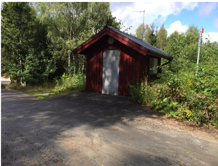
Figur 7. Spillvattenpumpstation vid Gamla Hyssnavägen
