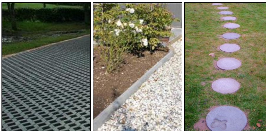
Figur 8. Yta med hålsten av betong, makadambelagd gång, samt gångstig med gräs och ett fåtal gångplattor
