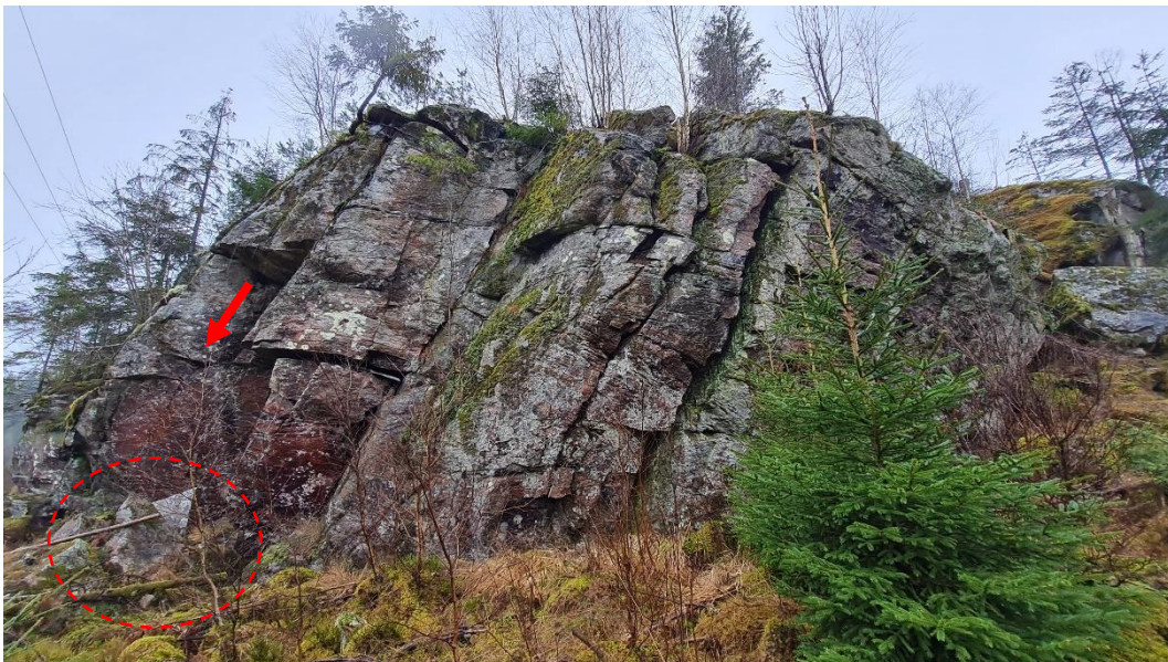
Figur 7. Foto från områdets sydöstra del visar ett uppsprucket bergparti. Block som fallit ut återfinns i släntfot (röd markering).
